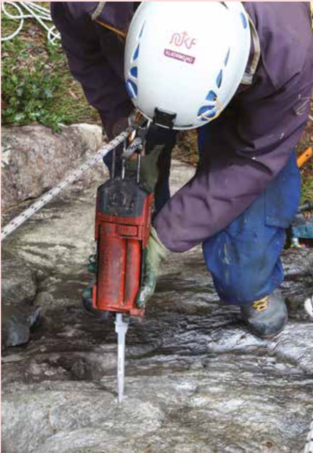
Ikke spar på limet – fyll hullet ca. 2/3.
