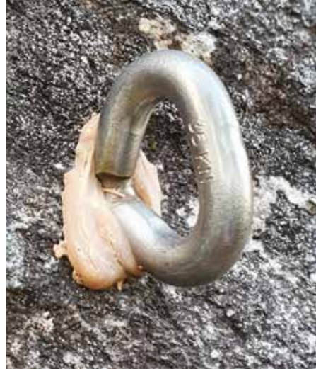
Limbolt – dårlig gjennomført.
